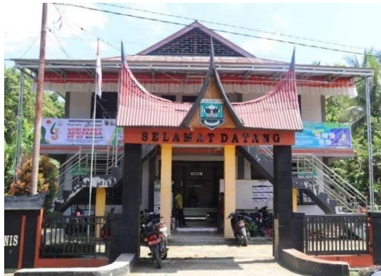
Gambar 4. 1 Kantor Wali Nagari Kumanis Sumber: dokumentasi pribadi peneliti
