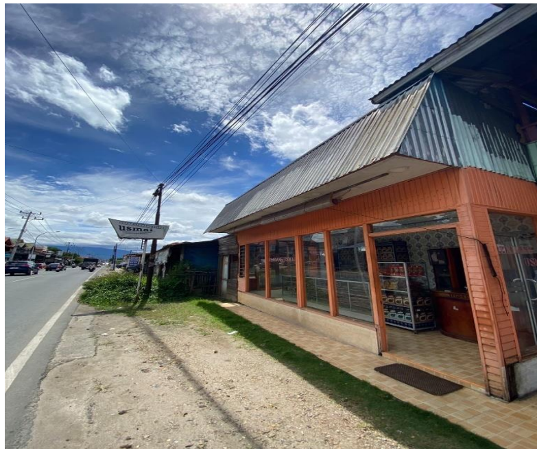
Gambar 4. 3 Tempat parkir yang tidak memadai
