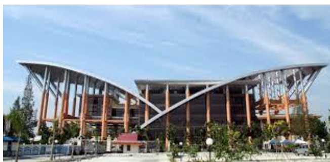
Gambar 4. 1 Gedung Dinas Perpustakaan dan Kearsipan Provinsi Riau
