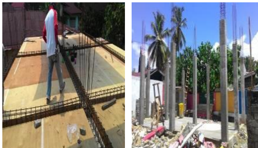
Gambar 4. 4 Kegiatan Pembangunan Mushalla di Lantai 2
