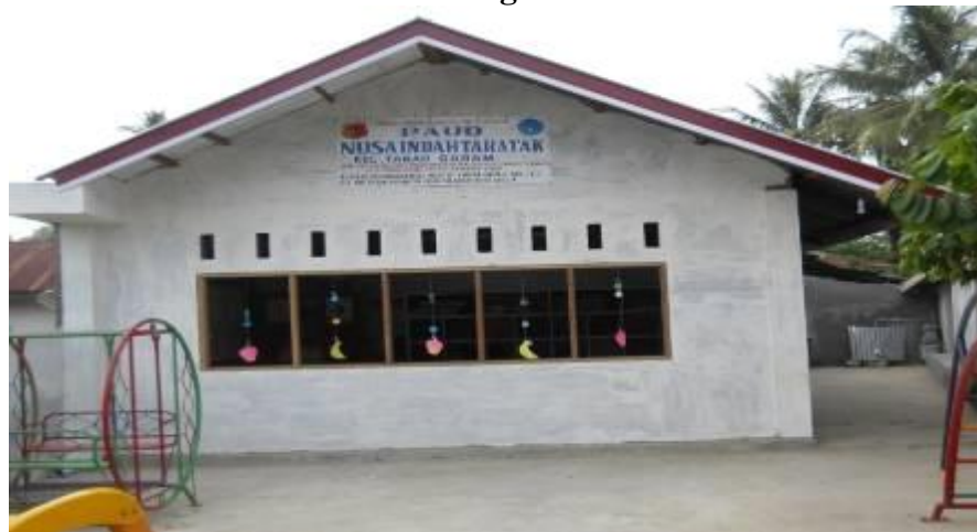
Gambar 4. 3 Kondisi sekolah pada awal renovasi Tahun 2013
