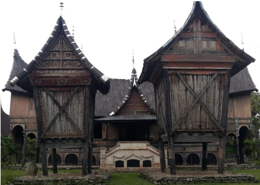
Rumah Adat Dt. Bandaro Kuniang, Limo Kaum, Kabupaten Tanah Datar
