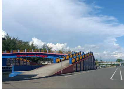
Gambar 4. 3 Akses Jalan Pantai Gandoriah
