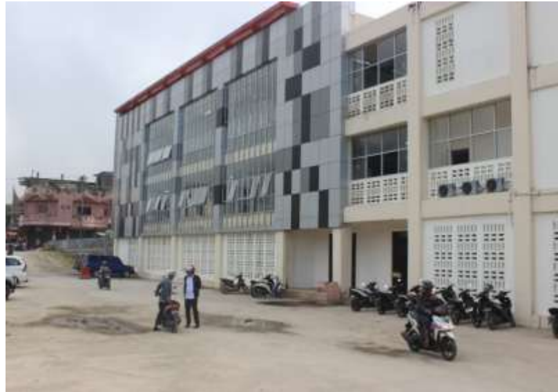
Gambar 4.3 Tampak Samping Gedung Pasar
