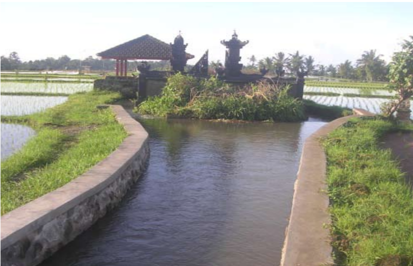
Gambar 8. Metpet munduk (betonisasi) pada Saluran Primer pada Subak Sigaran.
