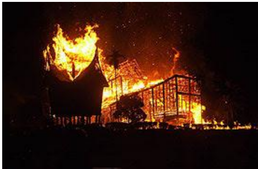
Gambar 2.1 : Istano Basa Pagaruyung Sewaktu terbakar Terbakar
